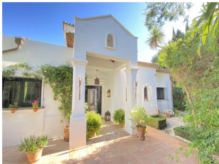
Eingangsbereich und Fassade
